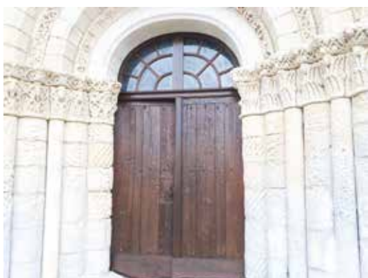
Réfection de la porte de l'église
